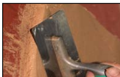
Etape 2 - application à la spatule inox ou à la machine à projeter, sur 1cm d'épaisseur.
